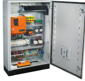
2- Tümleşik sürücü ile üretilmiş kumanda panosu
